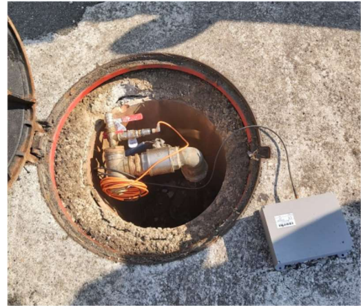
ISURLOG NB registrando presión de servicio en una red de distribución de agua potable
