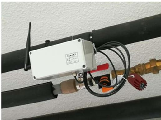
↑ data logger vía LoRa **ISURLOG-LR** midiendo el caudal y temperatura de un anillo ACS.
