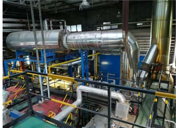
↑ Sala de cogeneración con bombas de recirculación ACS controladas por **IRIS BOX PC**
